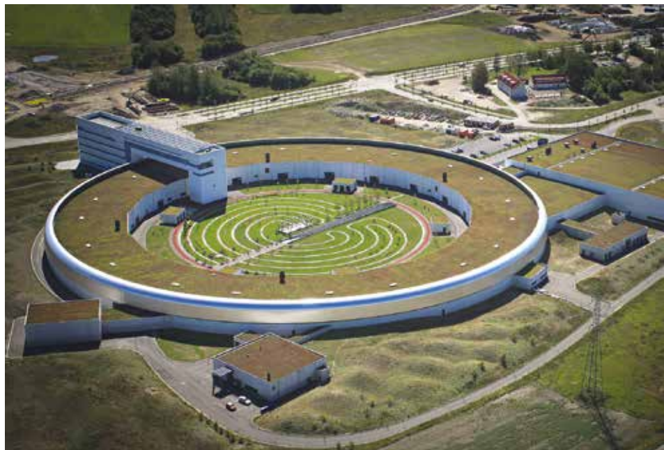
EFTER: MAX IV från 2016. Den stora lagringsringens omkrets är 528 meter, ungefär som Colosseum i Rom. Upptar med alla byggnader cirka 50 000 kvadratmeter. FOTO: PERRY NORDENG
